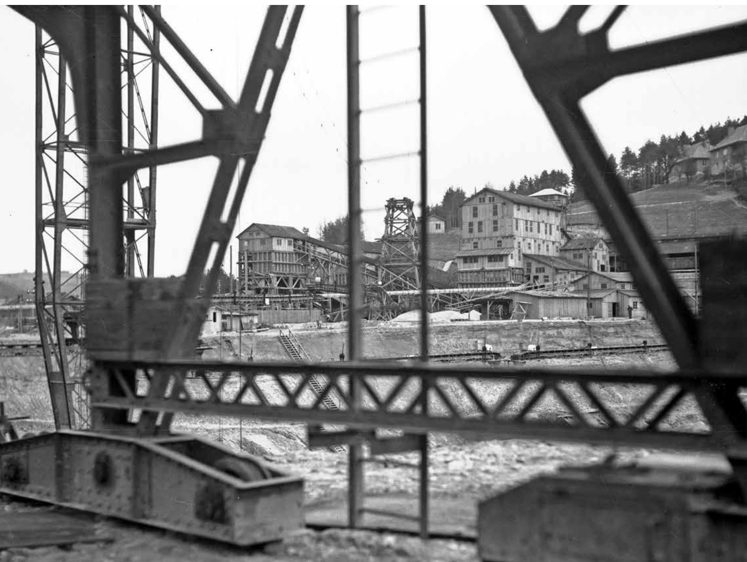
Budowa zapory w Rożnowie – jedna z inwestycji realizowanych w ramach Centralnego Okręgu Przemysłowego
