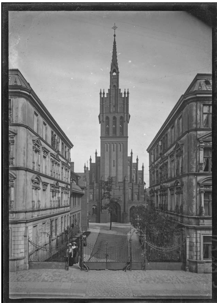
Królewiec. Widok z Oberhaberbergu na wzniesiony w latach 1904–1909 kościół katolicki Świętej Rodziny ( Zur Heiliger Familie ). Kościół zbudowany przez współpracującego z urzędem konserwatorskim architekta Fritza Heitmanna nawiązuje formą do katolickich świątyń z Warmii. Dziś mieści salę koncertową filharmonii. Fot. Oscar Bittrich
